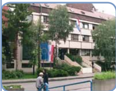
Nehajska MUP Buderus kondenzacijska kaskada 2x280KW
