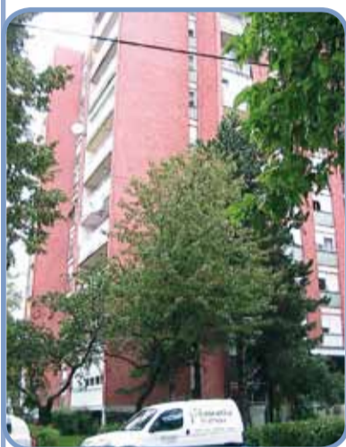
Božidarevićeva 7 10 vertikal, 54 kondenzacijska uređaja
